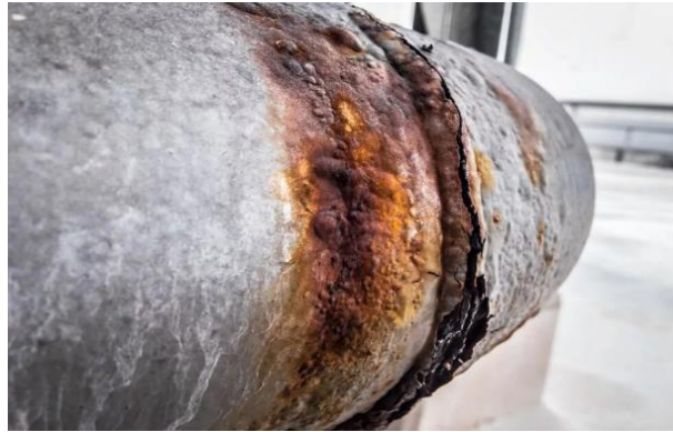
Рис. 3. Коррозионные повреждения трубопровода
