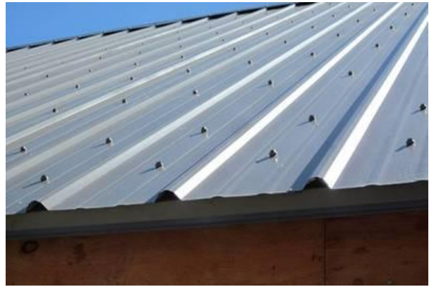
Рис. 3. Кровельные саморезы, вкрученные в деревянную обрешетку
