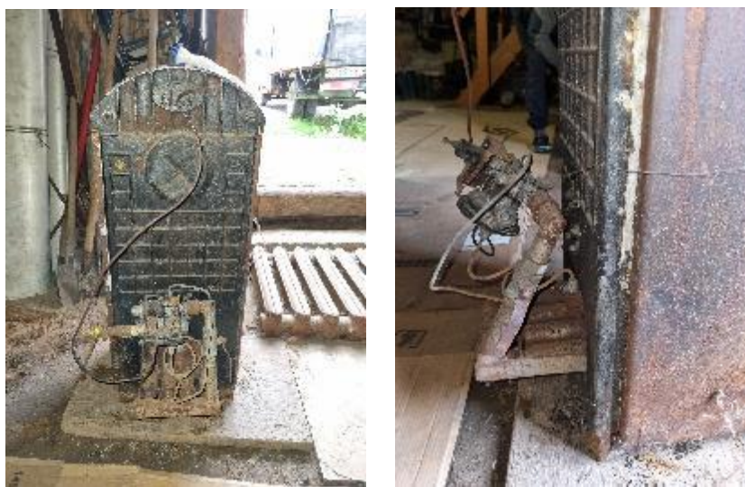
Рис. 1. Вид газового котла со стороны блока газовых горелок
