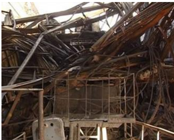
Рис. 1. Обрушение металлоконструкций при пожаре
