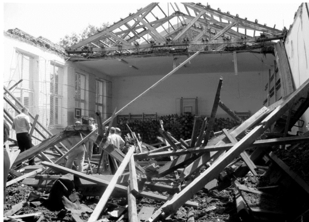
Рис.1. Обрушение деревянных конструкций кровли спортивного зала
