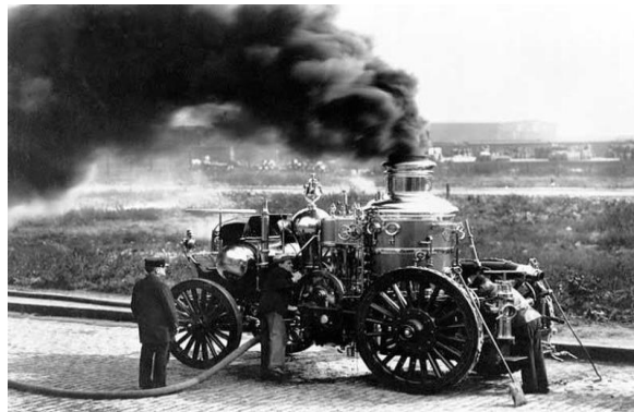
Рис. 3. Паровой насос
