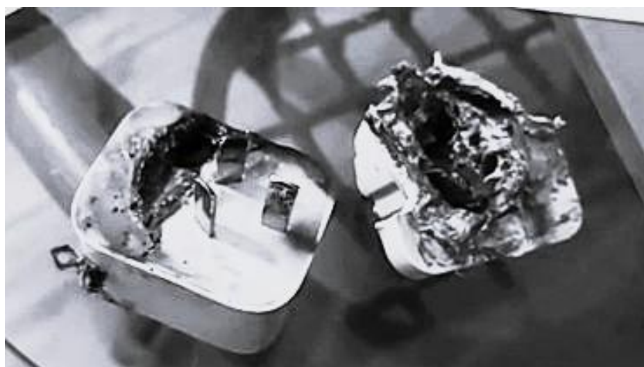
Рис. 3. Повреждение умной розетки из-за некачественного переходника
